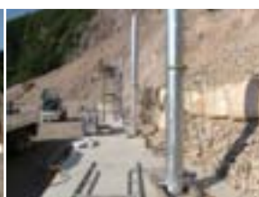
● 支柱建て込み
