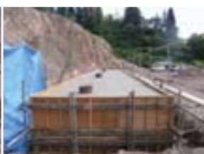
● コンクリート打設(下部工)
