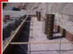
● 型枠施工状況(下部工)
