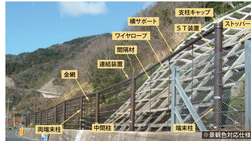
PCF工法(パワーキャッチフェンス工法)は、HRF工法の小規模タイプであり、高耐力・高靱性の支柱、エネルギー吸収機構の要である緩衝金具(ST装置)、落石衝突時にワイヤロープの間隔を保つ間隔材、ワイヤロープ、金網で構成した最大 500kJ の落石エネルギーに対応可能な高エネルギー吸収型落石防護柵です。
