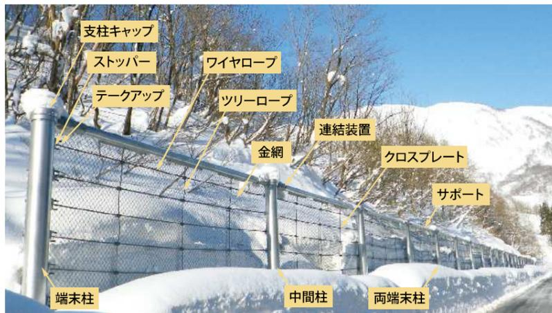
HSF工法（ハイパワースノーフェンス工法）は、雪崩予防・せり出し防止を目的とした工法であり、融雪時期における落石・表層崩壊等が懸念される箇所にも効果的です。
