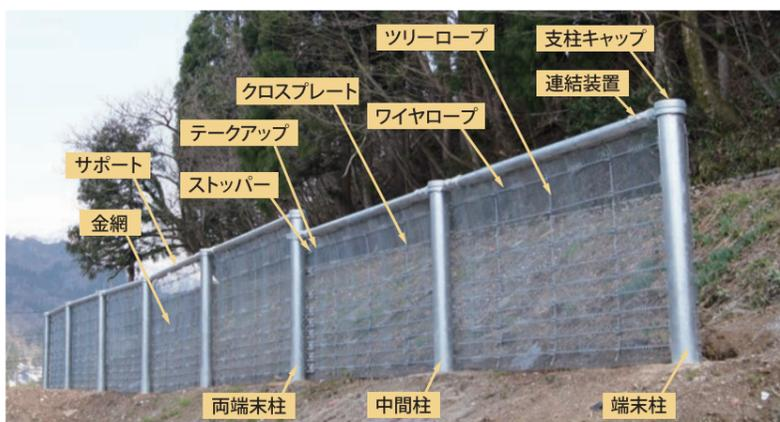
HEF工法（ハイパワーアースフェンス工法）は、斜面崩壊により発生した崩壊土砂防護を目的とした工法であり、実際の崩壊土砂を想定した実規模実証実験により防護性能を確認しています。
