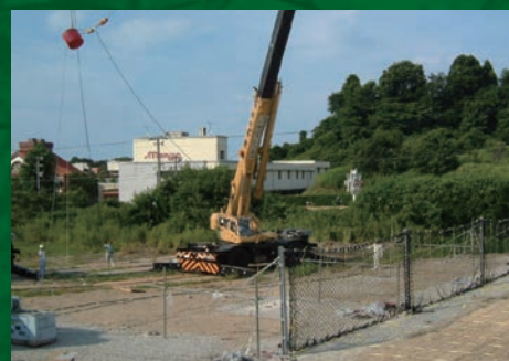
● 実規模実証実験 (重錘落下エネルギー E=200kJ)
