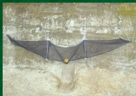
● 実規模実証実験 (重錘落下エネルギー E=100kJ)
